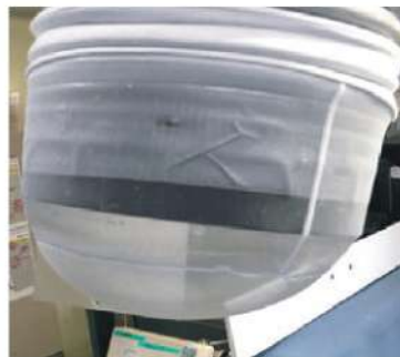
スポットクーラーにメッシュフィルター設置
